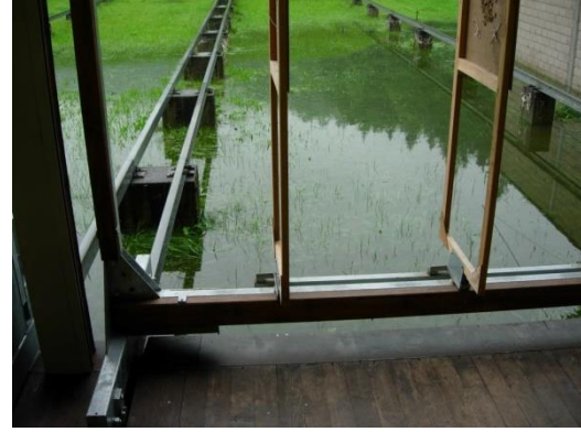
Abbildungen 2 Die Oberkante Betonsockel ist 55cm, Oberkante Schiene 70cm über Grund
