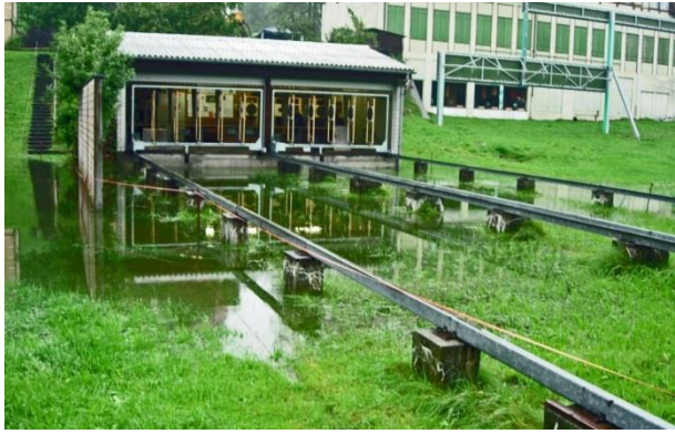
Abbildungen 2 Die Oberkante Betonsockel ist 55cm, Oberkante Schiene 70cm über Grund
